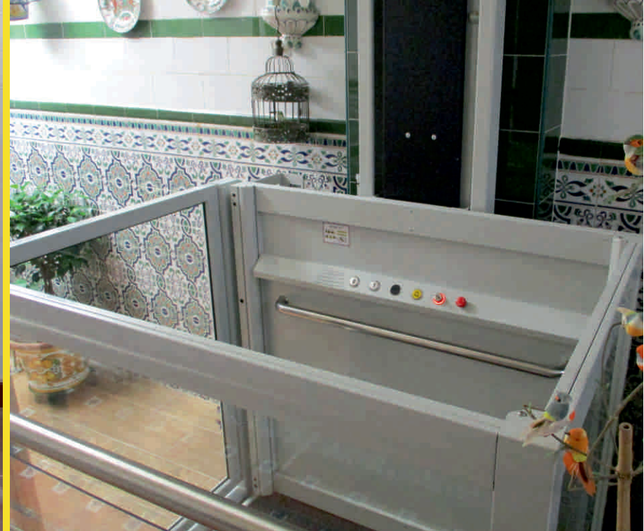
Botonera horizontal con stop tipo seta, llavín, alarma y pulsador de subida/bajada
