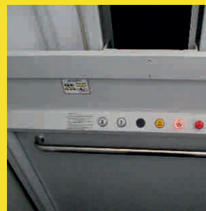
Botonera horizontal con stop tipo seta, llavín, alarma y pulsador de subida/bajada
