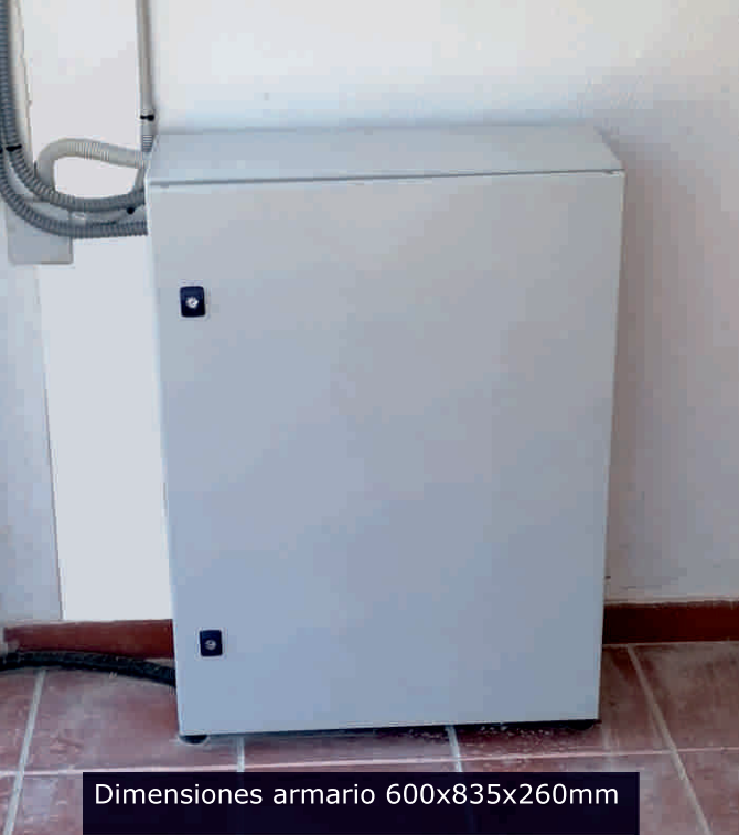
Armario de chapa para grupo hidráulico y cuadro eléctrico, con llave especial de apertura
